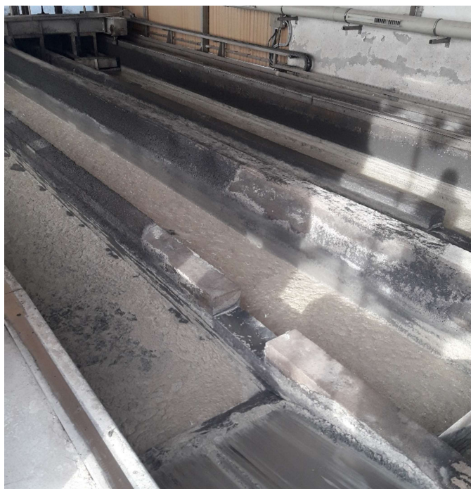
FIGURA 6 – Afluente com banhos de calcário (sulfuretos) - desengordurador/ desarenador dia 13/10/2019 (domingo) – 17:00 h
