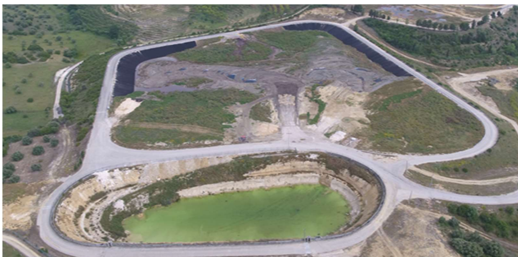
FIGURA 6 – Vista geral do Aterro de Lamas
