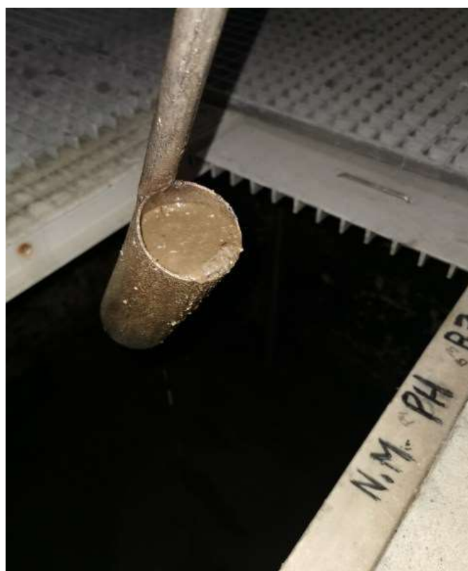
FIGURA 5 – Afluente com elevada concentração de gorduras na obra de entrada 11/10/2019 (sexta-feira) - 22:30h
