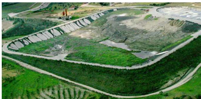
FIGURA 2 – Vista geral do ATERRO de Lamas
