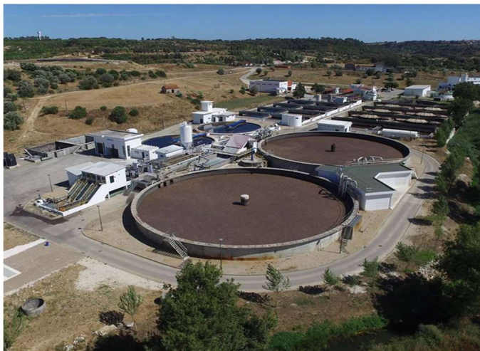
FIGURA 1 – Vista geral da ETAR de Alcanena
