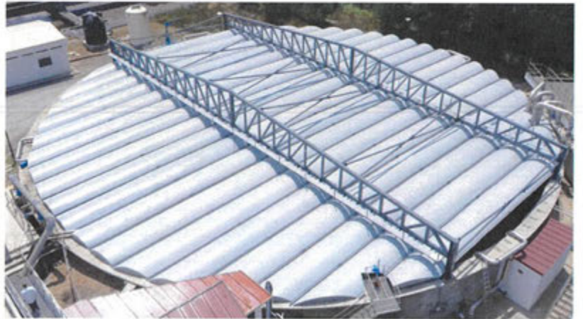
Cobertura dos Tanques de Equalização
