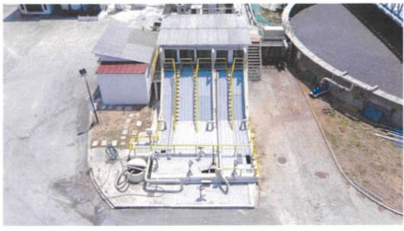
Obra de Entrada / Parafusos de Arquimedes
