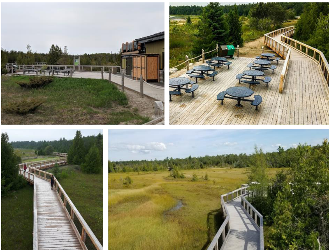
Figura 3.1 – Zonas húmidas construídas – “Bruce Peninsula National Park”.
