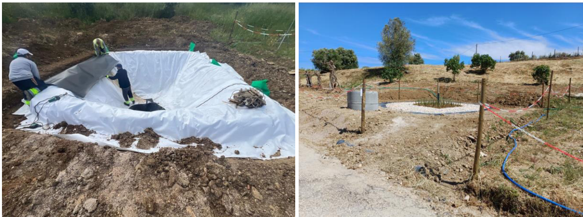
Figura 4.12. Processo de construção do Leito 03 (à esquerda) e Leito 03 concluído (à direita) (maio de 2025).
