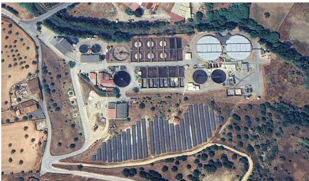
Figura 3.2 - Fotografia aérea da ETAR de Alcanena. Fonte: Google Earth.
