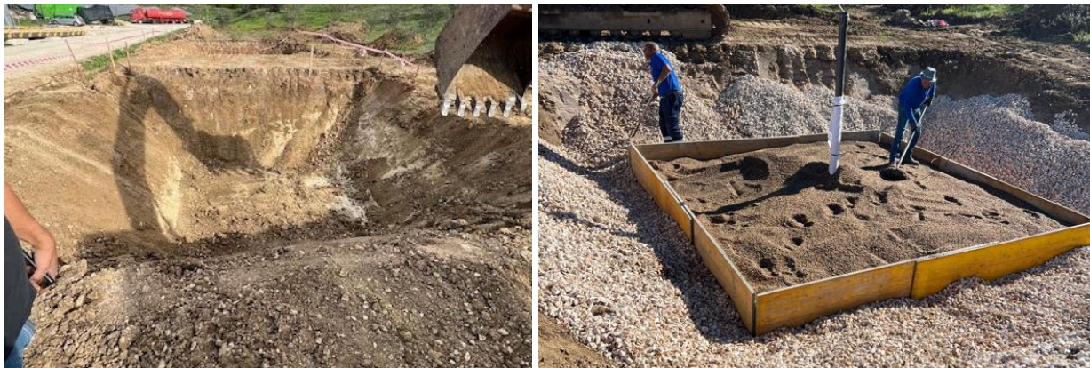
Figura 6.13 - Processo de construção das Unidades Piloto 01 e 02 (dezembro de 2024).
