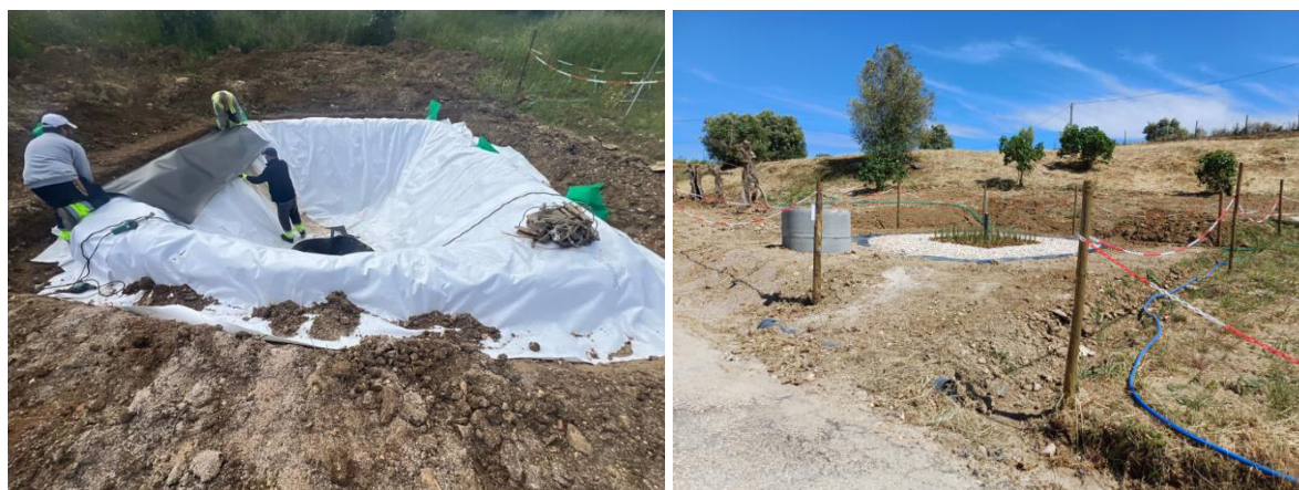
Figura 4.12. Processo de construção do Leito 03 (à esquerda) e Leito 03 concluído (à direita) (maio de 2025).
