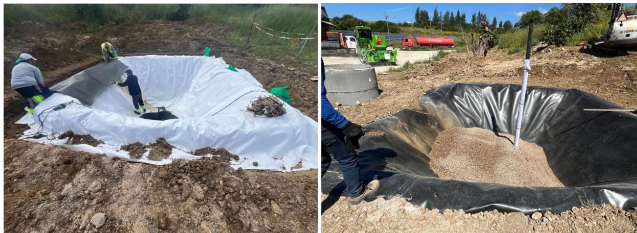
Figura 6.14 - Processo de construção da Unidade Piloto 03 (maio de 2025).
